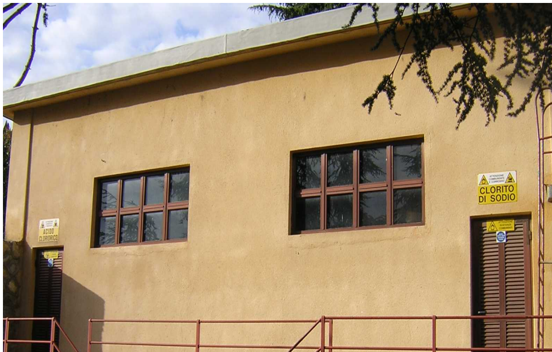
Fig.8:Generatore di biossido di cloro utilizzato nei processi di ossidazione e disinfezione delle acque destinate al consumo umano
