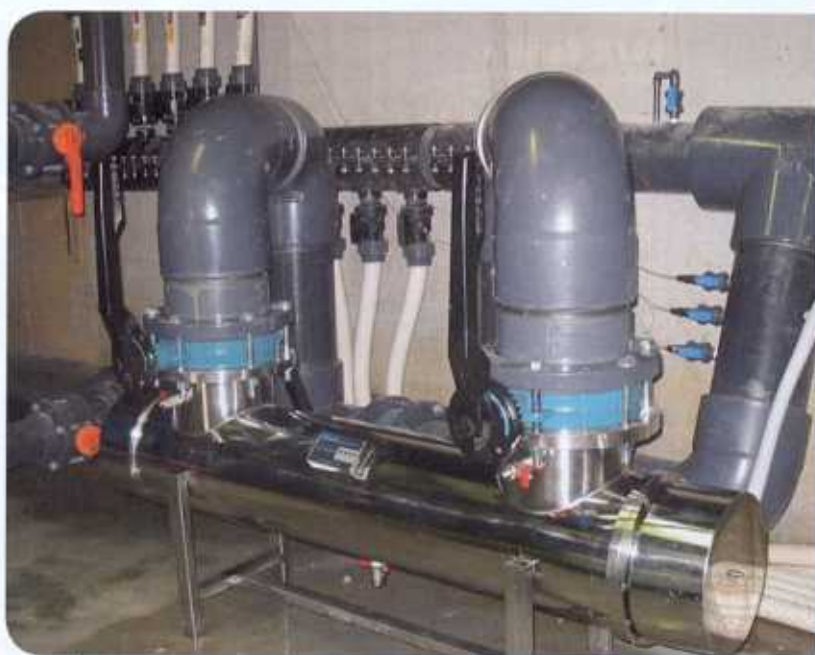
∴ UV 200/15 BE-VH - 320 m 3 /h, installato presso "Parco acquatico Acquajoy" Rivoli (TO)
