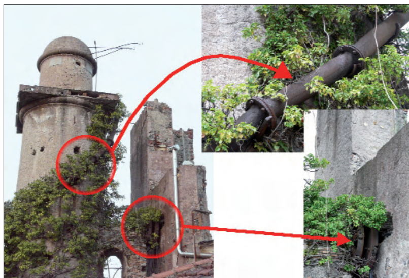
Fig. 15 – Resti della torre scalaria, della tubazione e del mozzo della ruota idraulica
