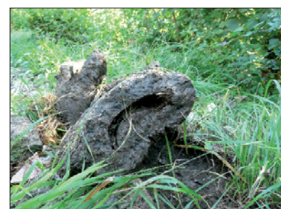
Fig. 8a/b – Resti della tubazione in cemento di forma ottagonale e in asfalto
