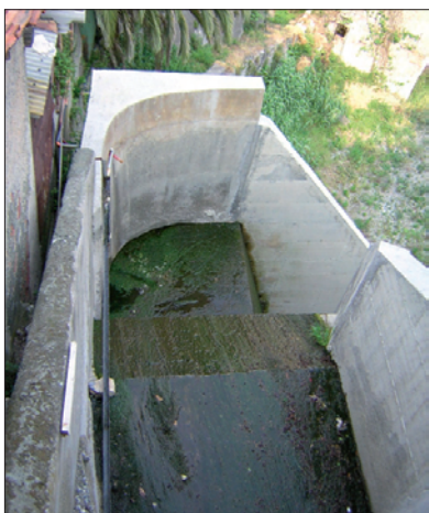
Fig. 17 – Scarico lungo il paramento a valle della diga
