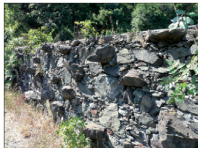
Fig. 5 – Particolare del coronamento
