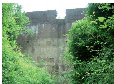
Fig. 7 – Diga superiore di Galano, paramento di monte
