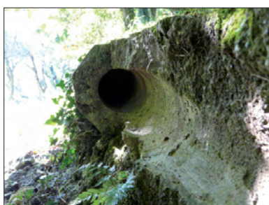
Fig. 8a/b – Resti della tubazione in cemento di forma ottagonale e in asfalto
