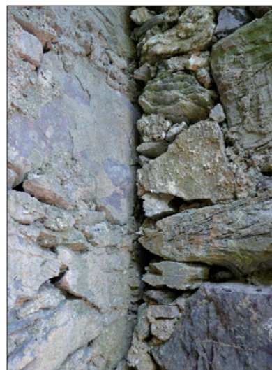
Fig. 12a/b – Particolare della copiosa incrostazione calcarea e della connessione contrafforte / corpo diga
