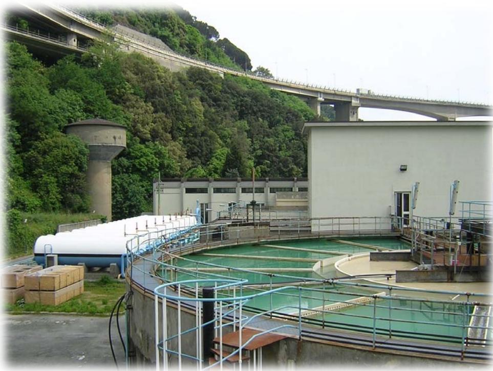
Particolare di un accelator e dei filtri a carbone attivo operativi presso l'impianto di Voltri (fonte: archivio Temporelli)
