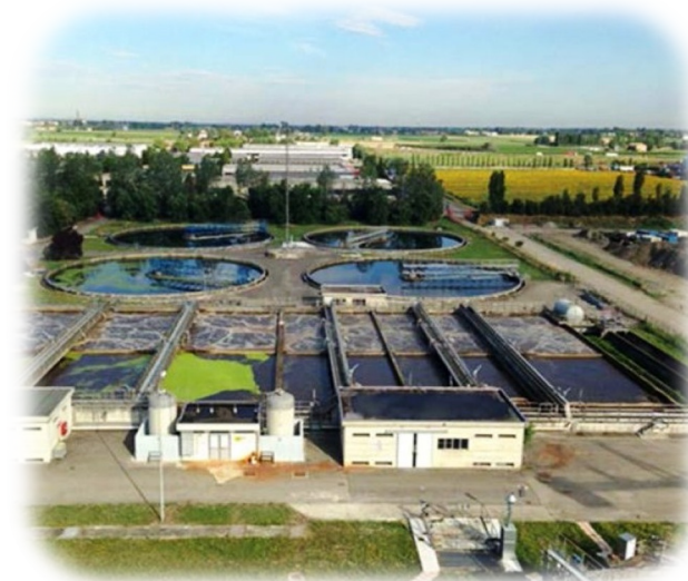
Depuratore “en plein air” Impianto di Mancasale (RE)
