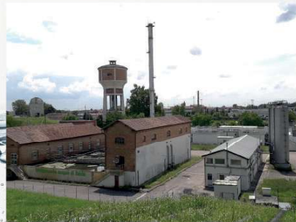
Figura 3: Vista dell'Impianto di Pontelagoscuro, sito nella provincia di Ferrara
